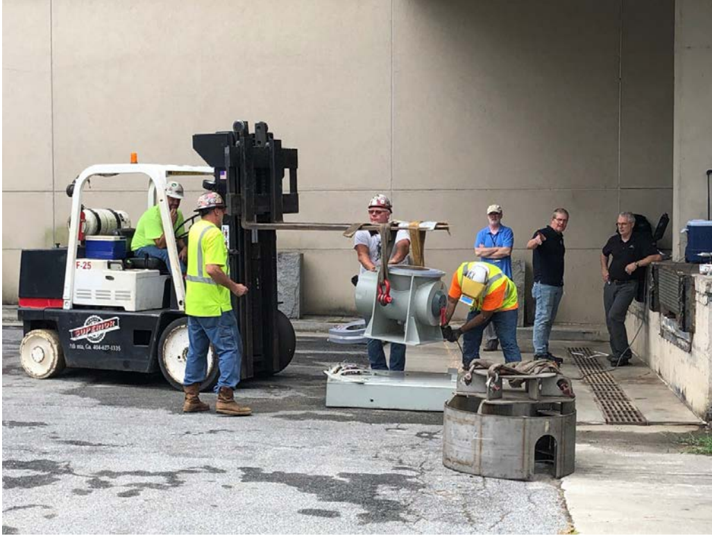
الشكل 2-1 إزالة مصدر الإشعاع من مستشفى جامعة إيموري باستخدام مشروع استبدال جهاز إشعاع السيزيوم. المصدر: من إنتاج المبادرة المتعلقة بالتهديد النووي.
