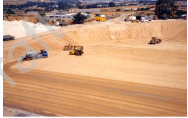
رسم توضيحي 2: تنفيذ طبقات العزل الأرضية
