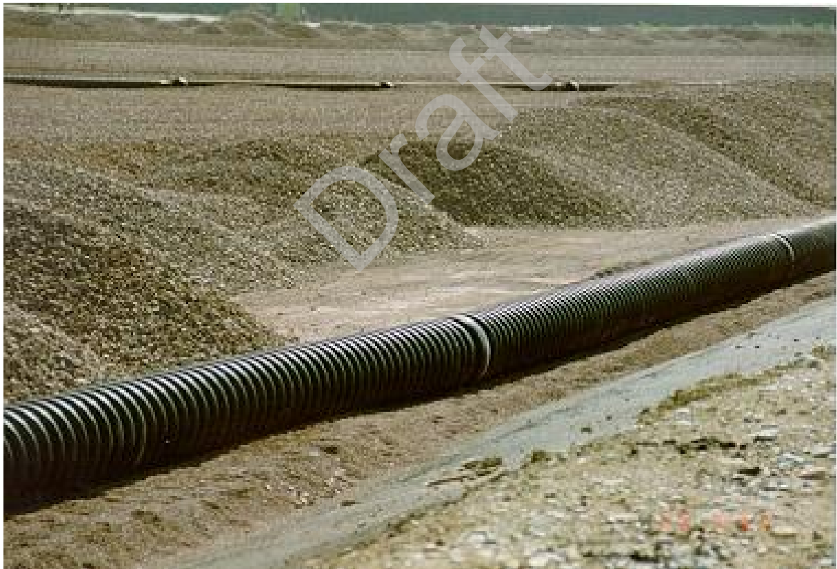
رسم توضيحي 6: تنفيذ نظام جمع المياه الراشحة
