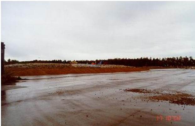
رسم توضيحي 3: تنفيذ طبقات العزل الأرضية بالأسفلت
