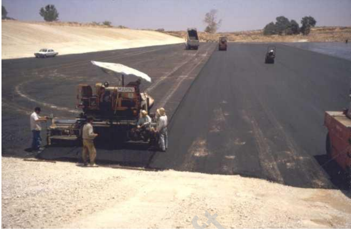
رسم توضيحي ٤: طبقات العزل الأرضية بالأسفلت
