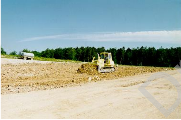
رسم توضيحي 2: تنفيذ طبقات العزل الأرضية
