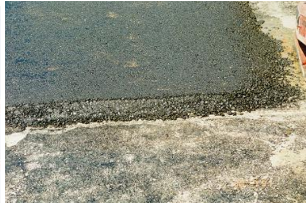
رسم توضيحي 3: تنفيذ طبقات العزل الأرضية بالأسفلت
