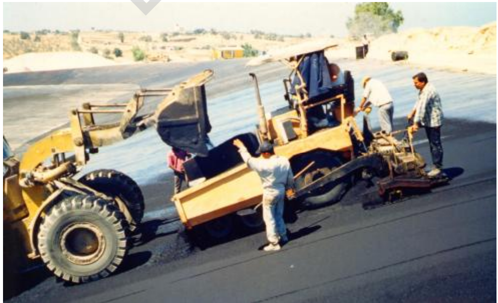
رسم توضيحي 5: تنفيذ طبقات العزل الجانبي بالأسفلت
